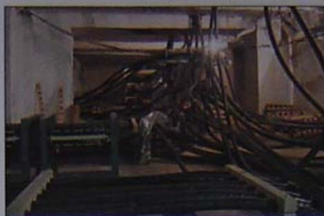
Část kabelového prostoru před rekonstrukcí
