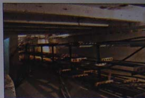
... a část rekonstruovaného kabelového prostoru.
