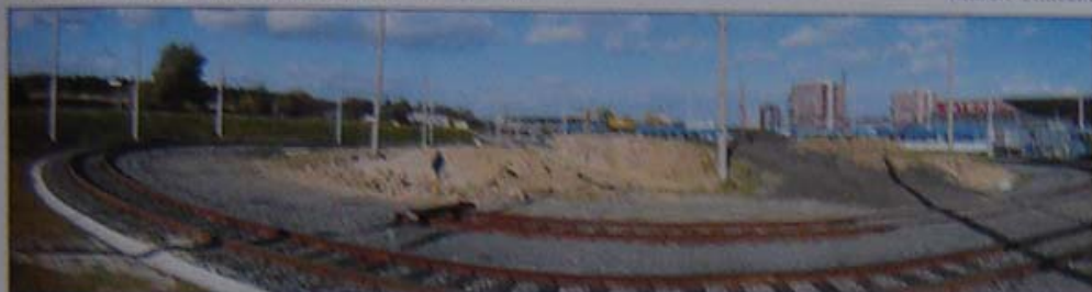
Uvnitř smyčky bude dobudována dvojkolej o užité délce 130 m, čímž se kapacita smyčky zvýší o 4 soupravy tramvají.
