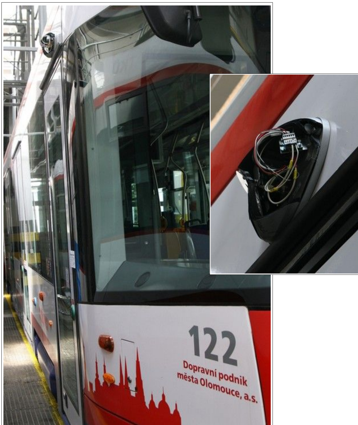
Obr. č. 8, 9: Následkem srážky s odstaveným SMV byl poškozen kryt kamery vnějšího kamerového systému DV, situovaný na pravé bočníci vozové skříň v prostoru nad 1. vstupními dveřmi (ve výřezu detail poškození krytu kamery).
